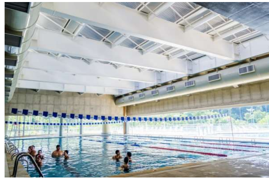
Figura 7 - Dutos Polipropileno - SESC Jundiaí
